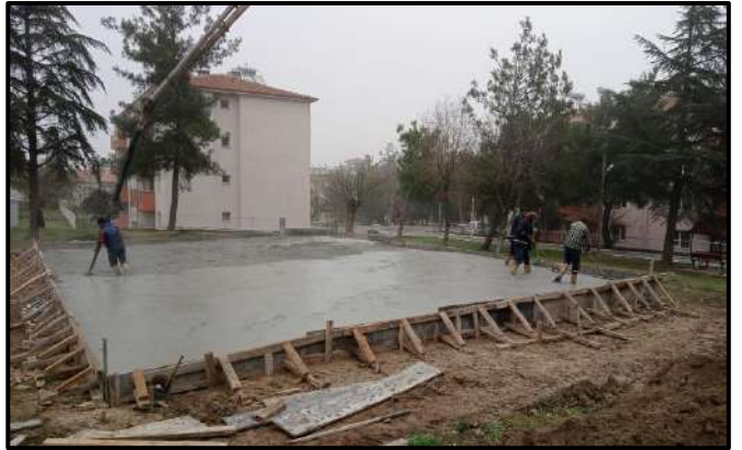
Hasan Basri Çantay Mh. Oyun Grubu Zemin Betonu Atılması İşi
